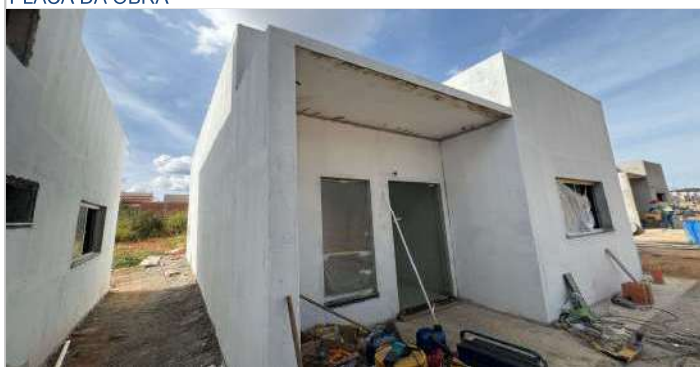
FACHADA E LATERAL
