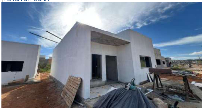
FACHADA E LATERAL ESQUERDA
