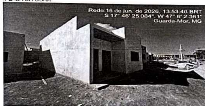
FACHADA E LATERAL
