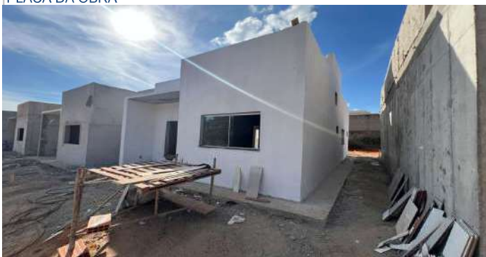
FACHADA E LATERAL
