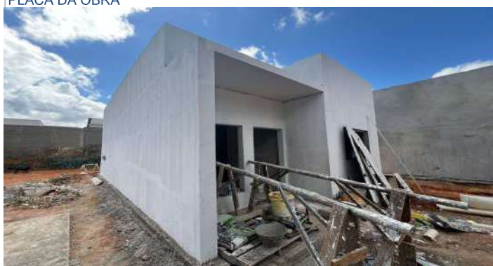
FACHADA E LATERAL
