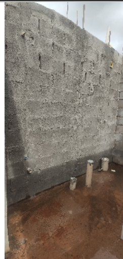
11-visão geral dos pontos elétricos e hidráulicos do banheiro casa 12 da quadra 14 08/01/25 15:02:08
