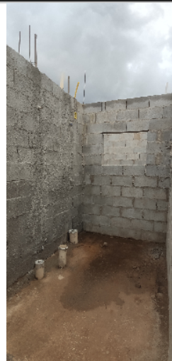
35-visão geral do banheiro casa 14 da quadra 14 08/01/25 15:14:21
