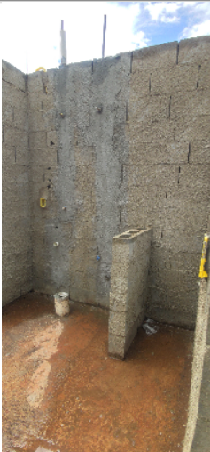
139-instalações de caixa elétrica 4x2 e rede de água e esgoto do tanque e máquina de lavar
