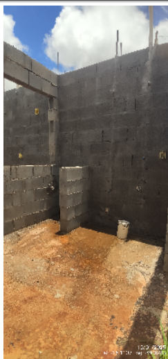
70-visão geral da área de serviço casa 28 da quadra 14 10/01/25 12:16:18
