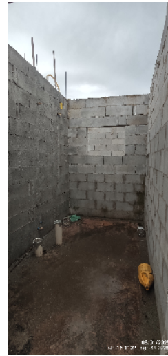
125-visão geral do banheiro da casa 22 da quadra 14 08/01/25 16:57:51
