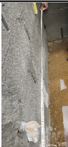
140-Ponto hidráulico da cozinha - Casa 56 10/01/25 12:46:43
