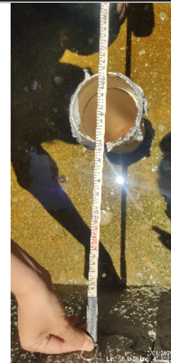
77-distância da parede do ponto de esgoto com o ponto do vaso sanitário casa 29 da quadra 14 10/01/25 12:20:00
