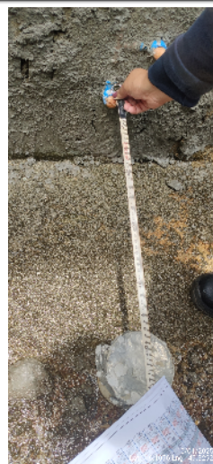
131-ponto do Vaso sanitário - casa 55 10/01/25 12:42:47
