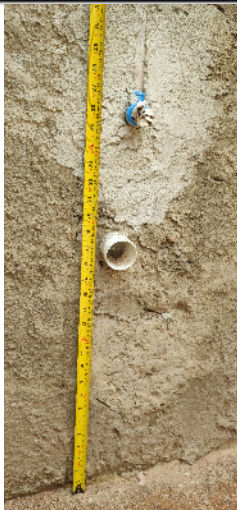
71-altura do ponto de água e esgoto da pia da cozinha
