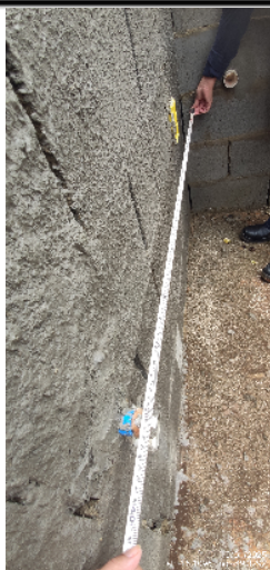
116-Ponto hidráulico da cozinha - casa 54 10/01/25 12:36:17
