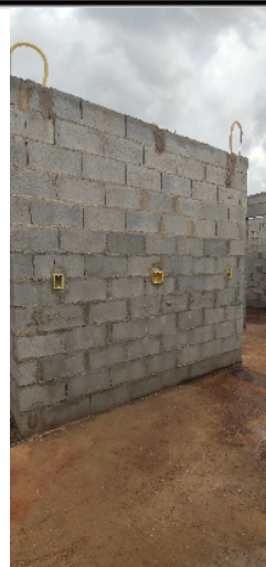
31-parte elétrica da sala casa 14 da quadra 14 08/01/25 15:12:06
