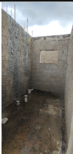
127-visão geral do banheiro 08/01/25 14:11:52
