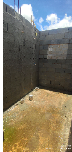
47-Visão geral banheiro - Casa 26 10/01/25 12:05:13
