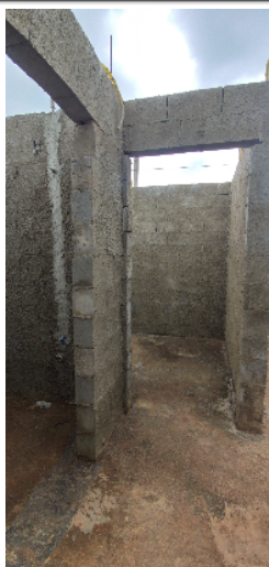
101-Dormitório 2 e banheiro 08/01/25 13:26:05
