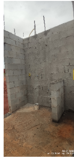
49-visão geral da área de serviço casa 15 da quadra 14 08/01/25 15:21:36
