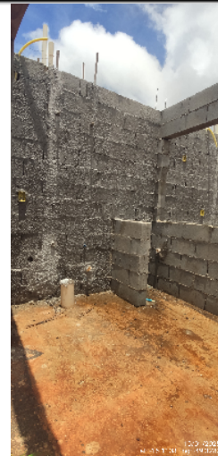
81-visão geral da área de serviço casa 29 da quadra 14 10/01/25 12:21:53
