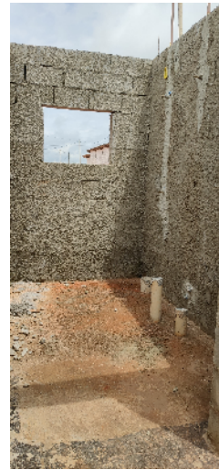
54-banheiro da casa 08 da quadra 14 08/01/25 11:12:47
