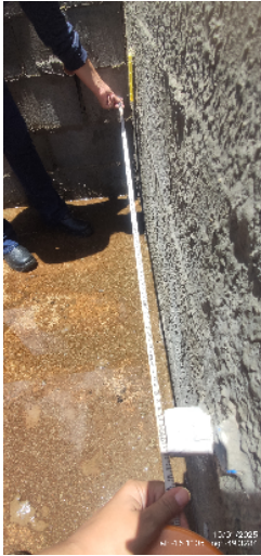
46-Ponto hidráulico cozinha - Casa 26 10/01/25 12:04:46
