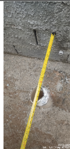
91-distância da parede com o ponto do vaso sanitário do banheiro da casa 19 da quadra 14 08/01/25 16:20:11
