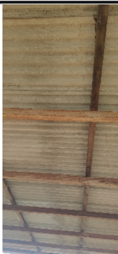
11-telhas do refeitório aproveitadas 08/01/25 09:51:04
