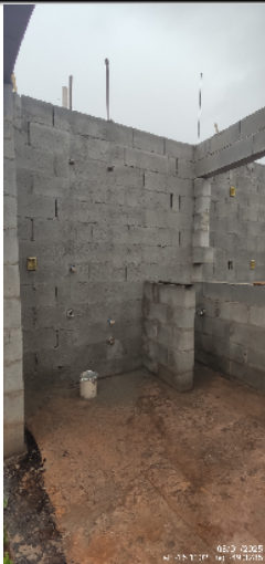
126-visão geral da área de serviço da casa 22 da quadra 14 08/01/25 16:58:15
