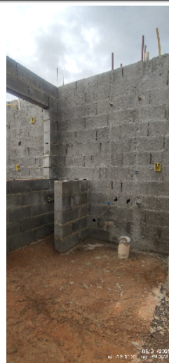
85-visão geral da área de serviço da casa 19 da quadra 14 08/01/25 16:16:48
