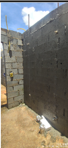
56-Pontos de hidráulica - Banheiro 10/01/25 12:08:55
