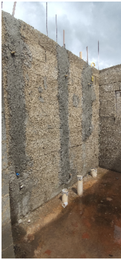
141-visão geral do pontos de água e esgoto do banheiro
