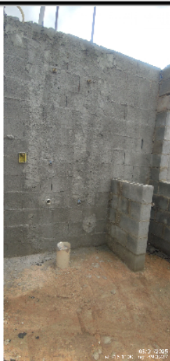
82-visão geral da área de serviço da casa 18 da quadra 14 08/01/25 16:15:17
