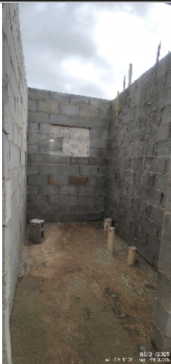
90-visão geral do banheiro da casa 19 da quadra 14 08/01/25 16:19:56
