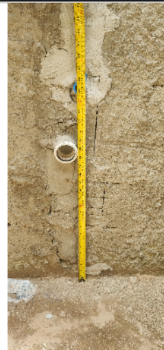
76-altura do ponto de água em relação ao piso casa 08 da quadra 14 08/01/25 11:39:06
