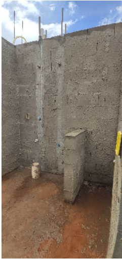
113-caixas elétrica 4x2 e instalações de água e esgoto do tanque e da máquina de lavar da casa 09 da quadra 14 08/01/25 13:57:35
