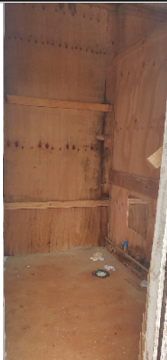
39-sanitário/vestiário 02 - aproveitamento do contra piso e sem aproveitamento do madeirite 08/01/25 10:19:37
