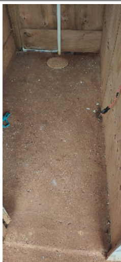
25-contrapiso do sanitário 02 08/01/25 10:09:35
