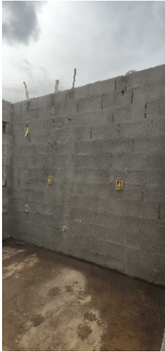
20-pontos elétricos e pontos de água e esgoto da cozinha casa 13 da quadra 14 08/01/25 15:06:46
