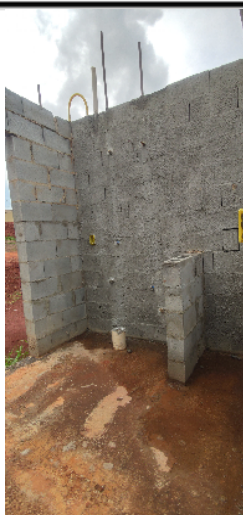
38-visão da área de serviço casa 14 da quadra 14 08/01/25 15:15:34
