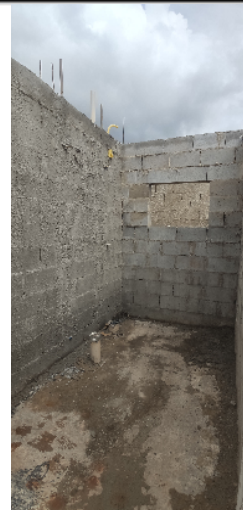
23-visão geral do banheiro casa 13 da quadra 14 08/01/25 15:08:20
