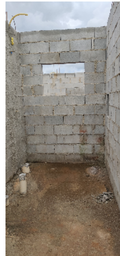
45-visão geral do banheiro casa 15 da quadra 14 08/01/25 15:19:32
