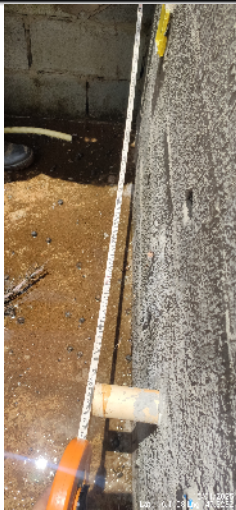
76-distância da parede ao ponto de esgoto da pia da cozinha casa 29 da quadra 14 10/01/25 12:19:03
