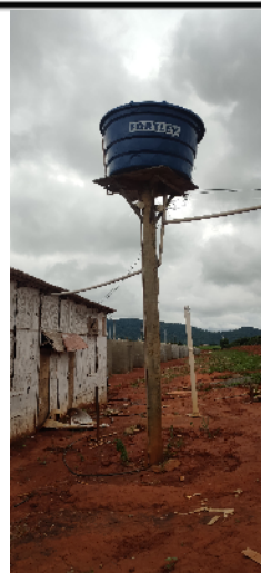
32-torre de caixa d' água feita em tronco de árvore sem aproveitamento 08/01/25 10:13:33
