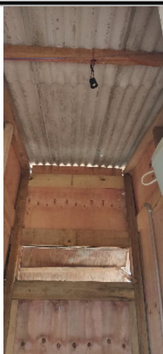
23-fazer novas instalações elétrica sanitário 1 08/01/25 10:08:02
