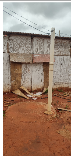
34-sumidouro com aproveitamento 08/01/25 10:14:58
