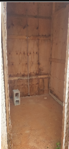
43-vestiário e sanitário 04 - aproveitamento do contra piso e sem aproveitamento do madeirite 08/01/25 10:22:55
