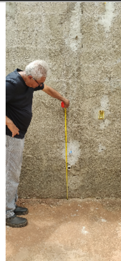
72-visão geral da altura do ponto de água e esgoto da pia da cozinha
