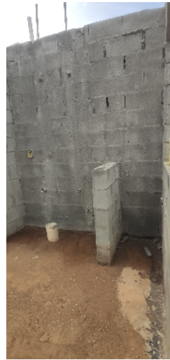
9-visão geral da área de serviço casa 12 da quadra 14 08/01/25 15:01:10
