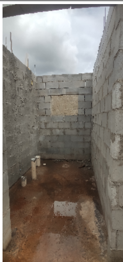
12-visão geral do banheiro casa 12 da quadra 14 08/01/25 15:02:46
