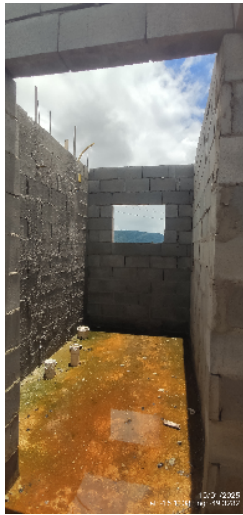
78-visão geral do banheiro casa 29;da quadra 14 10/01/25 12:20:44
