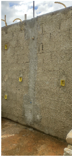
137-instalações de rede água e esgoto e caixa elétrica da cozinha
