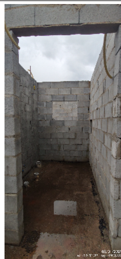
113-visão geral do banheiro da casa 21 da quadra 14 08/01/25 16:52:47
