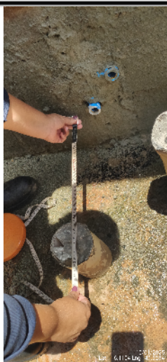
20-Ponto hidráulico - Banheiro casa 23 10/01/25 11:54:12
