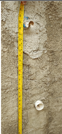
59-ponto de água da máquina de lavar
