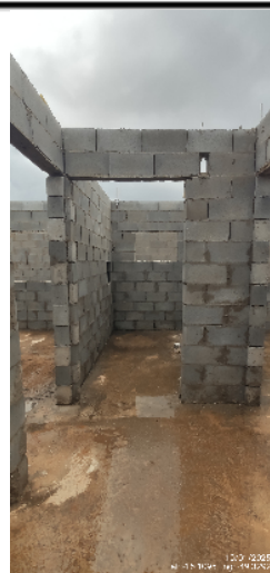
129-Visão geral - Banheiro 10/01/25 12:41:35
