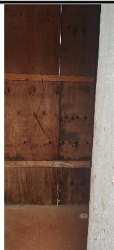
36-vestiário/sanitário 01 - sem aproveitamento do madeirite 08/01/25 10:16:25
