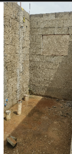
116-visão geral do banheiro casa 09 da quadra 14 08/01/25 14:01:20
