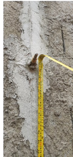
66-altura do registro do tanque e da máquina de lavar
