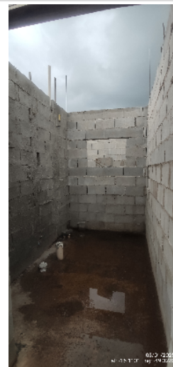
101-visão geral do banheiro da casa 20 da quadra 14 08/01/25 16:26:07
