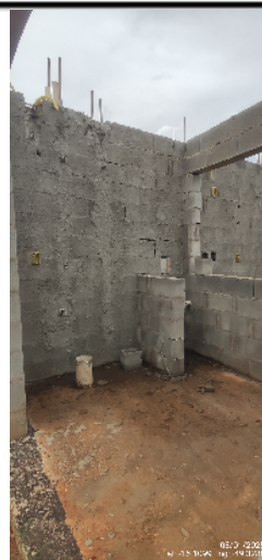
63-visão geral da área de serviço casa 17 da quadra 14 08/01/25 15:29:22
