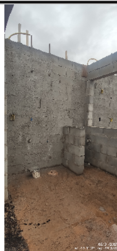
107-visão geral da área de serviço da casa 21 da quadra 14 08/01/25 16:49:14
