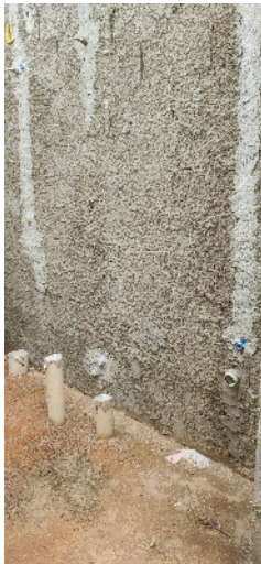
73-visão geral das tubulações do banheiro 08/01/25 11:31:38
