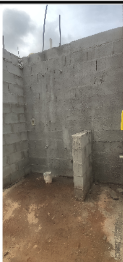
26-visão geral da área de serviço casa 13 da quadra 14 08/01/25 15:09:35
