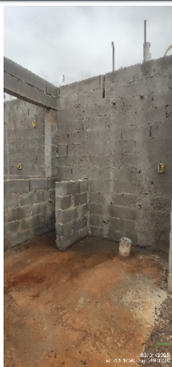
60-visão geral da área de serviço casa 16 da quadra 14 08/01/25 15:27:54
