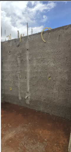
111-caixas elétrica 4x2 e instalações de água e esgoto da cozinha da casa 09 da quadra 14 08/01/25 13:56:09
