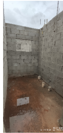
57-visão geral do banheiro casa 15 da quadra 14 08/01/25 15:26:32
