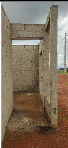
119-entrada casa 10 da quadra 14 08/01/25 14:05:59
