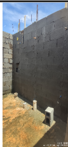
21-Visão geral - banheiro - casa 23 10/01/25 11:54:28
