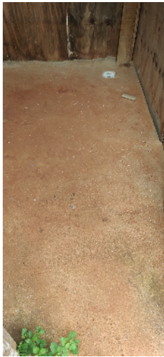
37-sanitário/vestiário 01 - contra piso para aproveitamento 08/01/25 10:18:17
