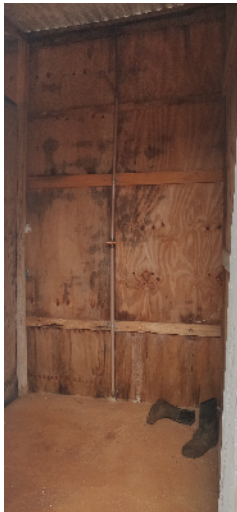
41-vestiário/sanitário 03 - aproveitamento do contra piso e sem aproveitamento do madeirite 08/01/25 10:21:07
