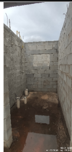
67-visão geral do banheiro casa 17 da quadra 14 08/01/25 15:32:19
