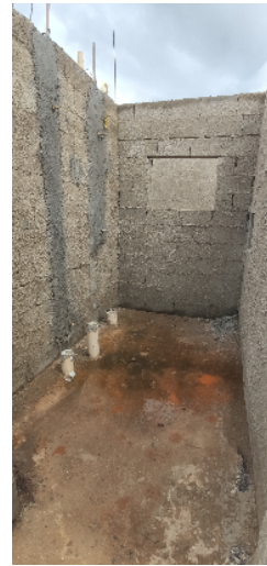
142-visão geral do banheiro
