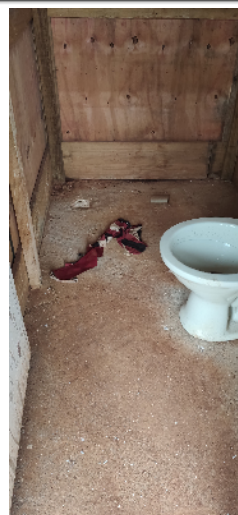
26-contrapiso do sanitário 01 08/01/25 10:09:57
