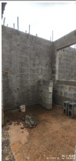
104-visão geral da área de serviço da casa 20 da quadra 14 08/01/25 16:27:27
