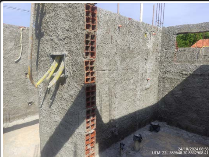
26-Quadra 11 Lote 11 - Pontos elétricos e Hidráulicos no banheiro UTM: 22L 589648.70 8532908.41 - 24/10/2024
