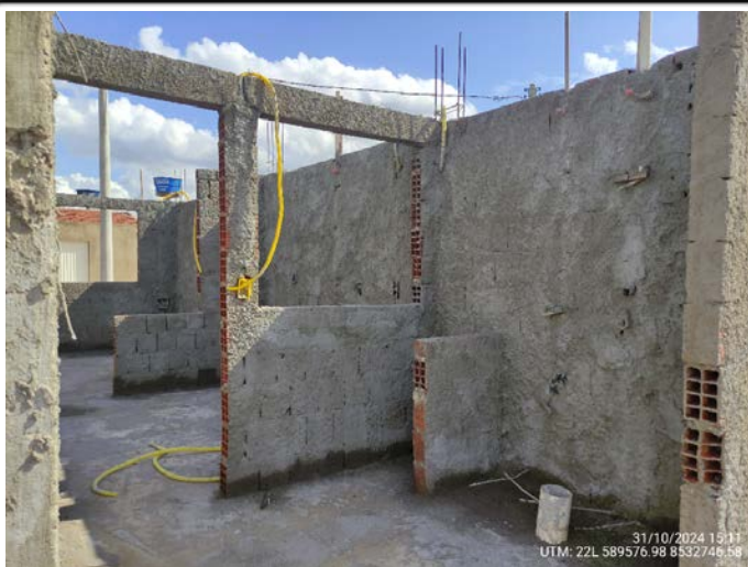
5-Quadra 08 Lote 02- infra elétrica e hidráulica UTM: 22L 589576.98 8532746.58 - 31/10/2024
