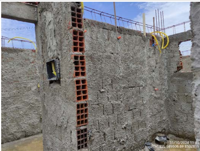
81-Quadra 21 Lote 14- infra elétrica e hidráulica banheiro UTM: 22L 589606.69 8532816 - 31/10/2024
