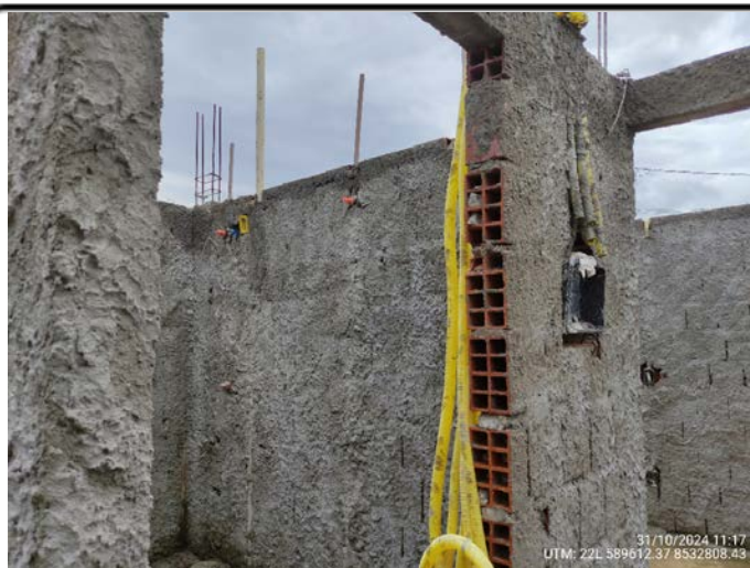
39-Quadra 21 Lote 07- infra elétrica e hidráulica banheiro UTM: 22L 589612.37 8532808.43 - 31/10/2024
