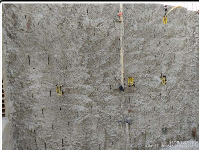
18-Unidade 10 - pontos Hidráulicos e elétricos na cozinha UTM: 22L 589646.28 8532918.62 - 24/10/2024
