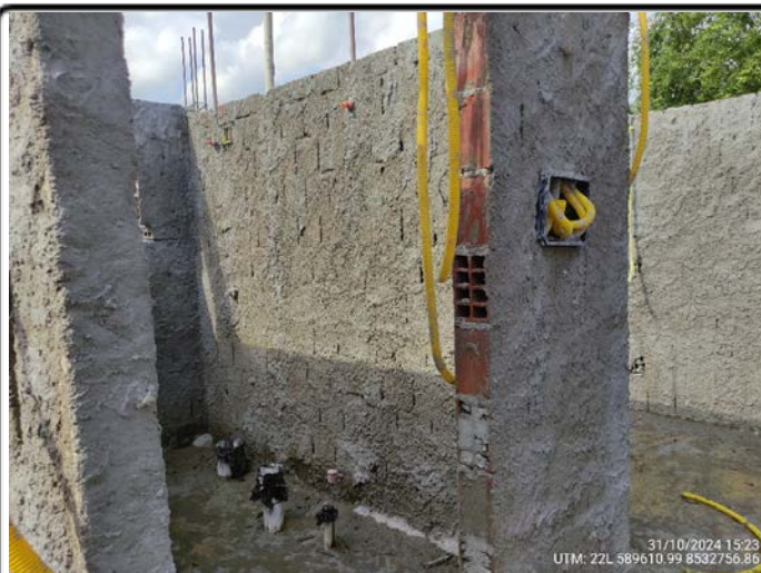
28-Quadra 08 Lote 06- infra elétrica e hidráulica banheiro UTM: 22L 589610.99 8532756.86 - 31/10/2024
