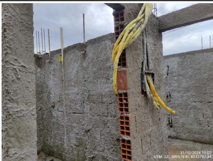
21-Quadra 21 Lote 04- infra elétrica e hidráulica banheiro UTM: 22L 589578.81 8532797.34 - 31/10/2024
