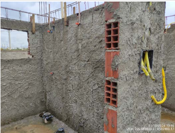
33-Quadra 12 Lote 06 - infra das instalações hidráulicas e elétricas posicionadas banheiro UTM: 22L 589600.27 8532900.17 - 31/10/2024
