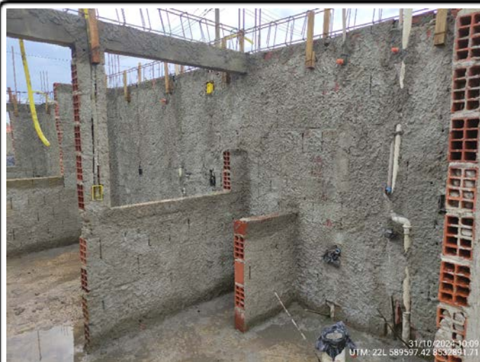
26-Quadra 12 Lote 05 - infra das instalações hidráulicas e elétrica de registros UTM: 22L 589597.42 8532891.71 - 31/10/2024
