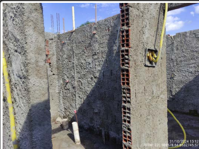
6-Quadra 08 Lote 02- infra elétrica e hidráulica banheiro UTM: 22L 589578.64 8532745.57 - 31/10/2024
