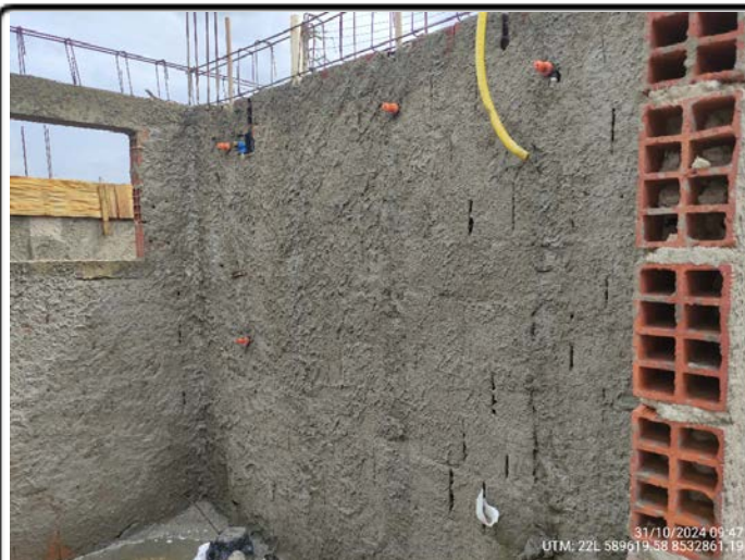
8-Quadra 12 Lote 02 - tubulações hidráulicas e elétricos do banheiro posicionadas UTM: 22L 589619.58 8532861.19 - 31/10/2024
