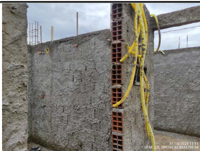
27-Quadra 21 Lote 05- infra elétrica e hidráulica banheiro UTM: 22L 589590.63 8532799.54 - 31/10/2024
