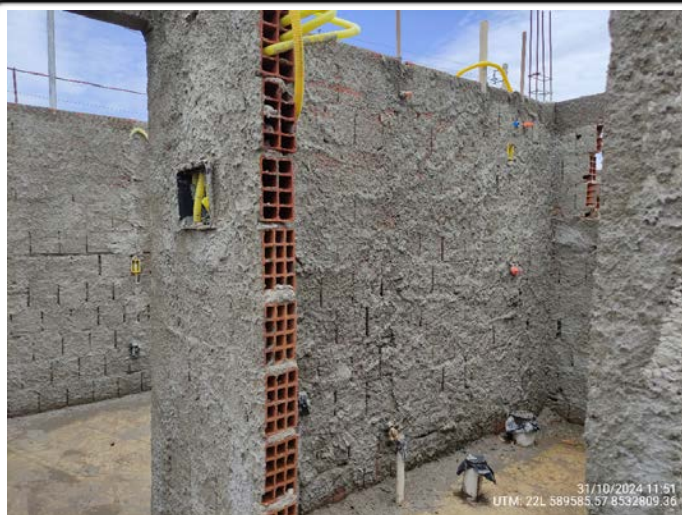
93-Quadra 21 Lote 16- infra elétrica e hidráulica banheiro UTM: 22L 589585.57 8532809.36 - 31/10/2024
