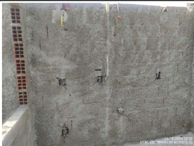
25-Quadra 11 Lote 11 - Pontos elétricos e Hidráulicos na cozinha UTM: 22L 589651.50 8532910.32 - 24/10/2024
