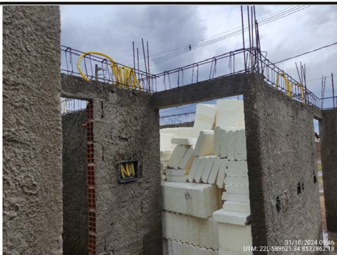
7-Quadra 12 Lote 02 - armaduras das vigas superiores posicionados UTM: 22L 589621.34 8532862.18 - 31/10/2024
