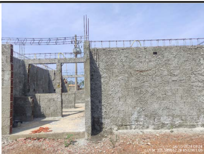
31-Quadra 11 Lote 12 - fachada posterior armaduras de vigas posicionadas UTM: 22L 589652.28 8532901.05 - 24/10/2024
