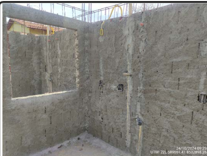
36-Quadra 11 Lote 13 - pontos de hidráulica e elétrica cozinha e área de serviço UTM: 22L 589661.41 8532898.26 - 24/10/2024
