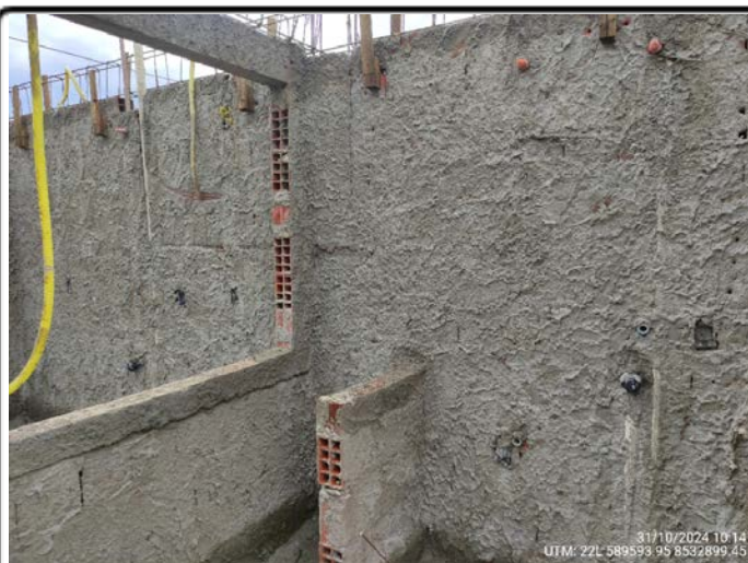
32-Quadra 12 Lote 06 - infra das instalações hidráulicas e elétricas posicionadas UTM: 22L 589593.95 8532899.45 - 31/10/2024
