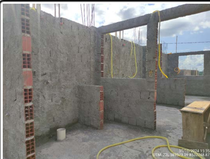
50-Quadra 08 Lote 10- infra elétrica e hidráulica UTM: 22L 589579.09 8532748.87 - 31/10/2024
