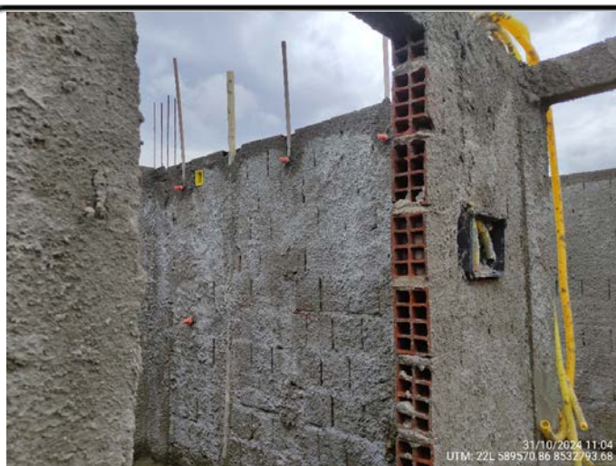
15-Quadra 21 Lote 03- infra elétrica e hidráulica banheiro UTM: 22L 589570.86 8532793.68 - 31/10/2024
