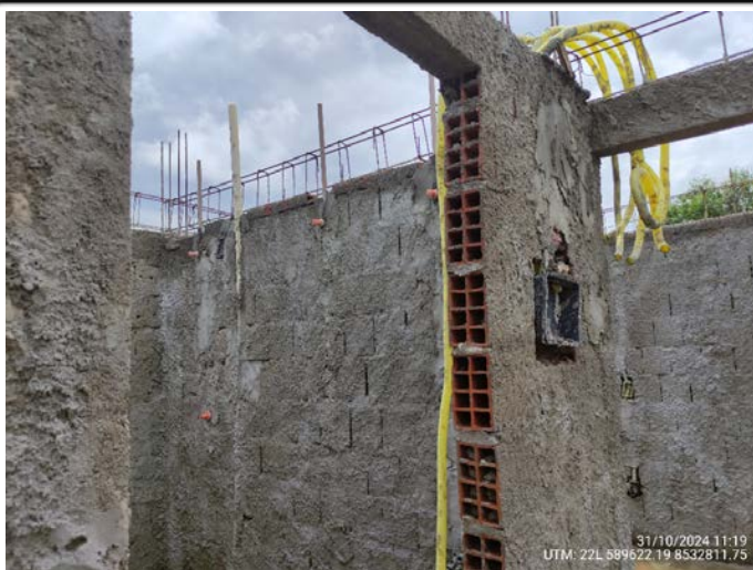
45-Quadra 21 Lote 08- infra elétrica e hidráulica banheiro UTM: 22L 589622.19 8532811.75 - 31/10/2024
