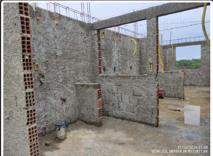
86-Quadra 21 Lote 15- infra elétrica e hidráulica UTM: 22L 589599.38 8532811.66 - 31/10/2024
