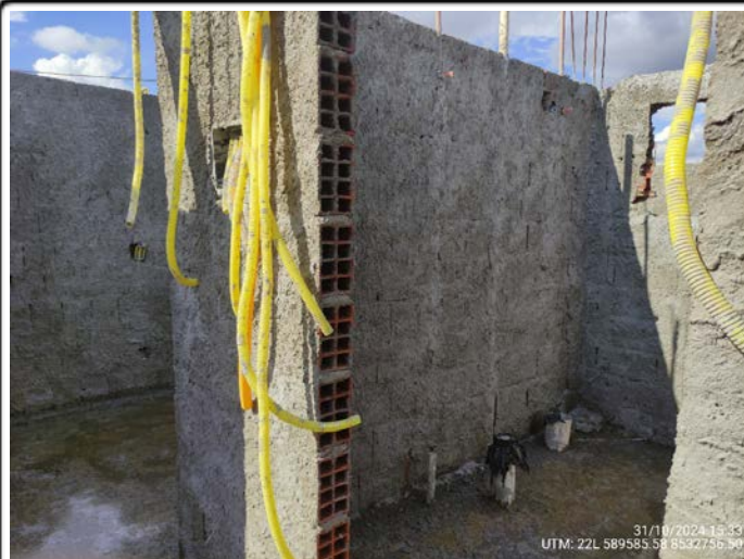
46-Quadra 08 Lote 09- infra elétrica e hidráulica banheiro UTM: 22L 589585.58 8532756.50 - 31/10/2024
