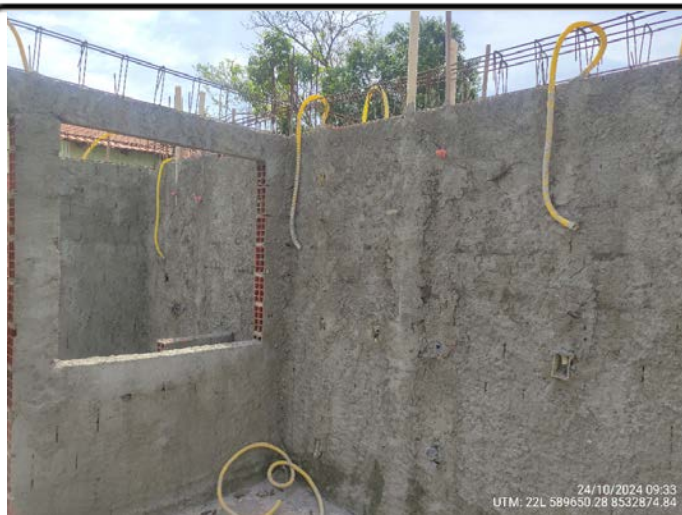
39-Quadra 11 lote 14 - pontos hidráulico e elétricos, armadura de viga posicionada UTM: 22L 589650.28 8532874.84 - 24/10/2024
