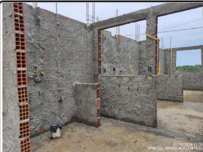
92-Quadra 21 Lote 16- infra elétrica e hidráulica UTM: 22L 589585.26 8532810.23 - 31/10/2024
