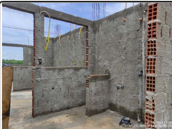
108-Quadra 21 Lote 19- infra elétrica e hidráulica UTM: 22L 589564.63 8532797.24 - 31/10/2024
