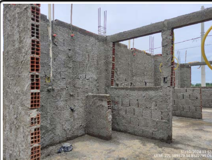
98-Quadra 21 Lote 17- infra elétrica e hidráulica UTM: 22L 589579.54 8532799.06 - 31/10/2024
