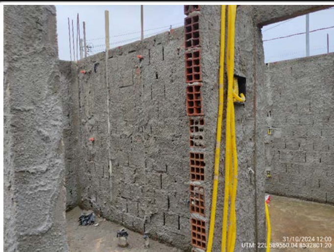
109-Quadra 21 Lote 19- infra elétrica e hidráulica banheiro UTM: 22L 589560.04 8532801.20 - 31/10/2024
