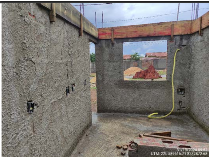
15-Quadra 12 Lote 03 - tubulação elétricas e hidráulicas posicionados UTM: 22L 589616.71 8532872.68 - 31/10/2024
