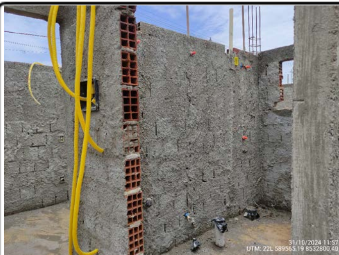
104-Quadra 21 Lote 18- infra elétrica e hidráulica banheiro UTM: 22L 589565.19 8532800.40 - 31/10/2024
