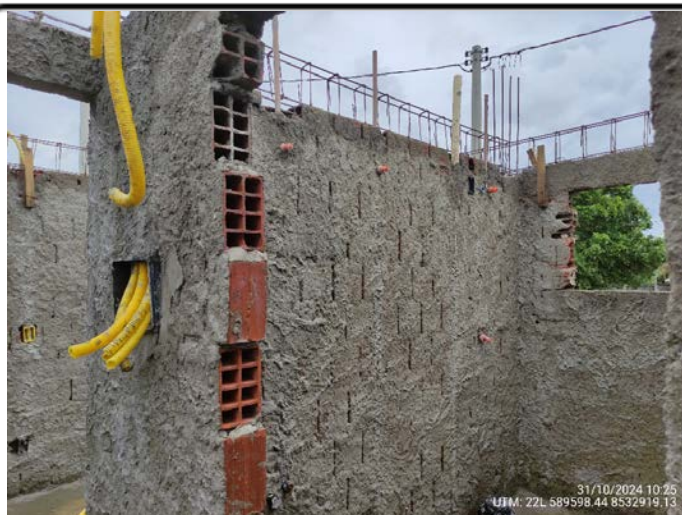
39-Quadra 12 Lote 07 - infra elétrica e hidráulica posicionada no banheiro UTM: 22L 589598.44 8532919.13 - 31/10/2024
