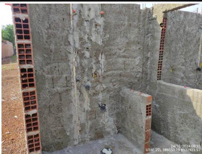
17-Unidade 10 - pontos Hidráulicos Área de serviço UTM: 22L 589653.19 8532923.97 - 24/10/2024
