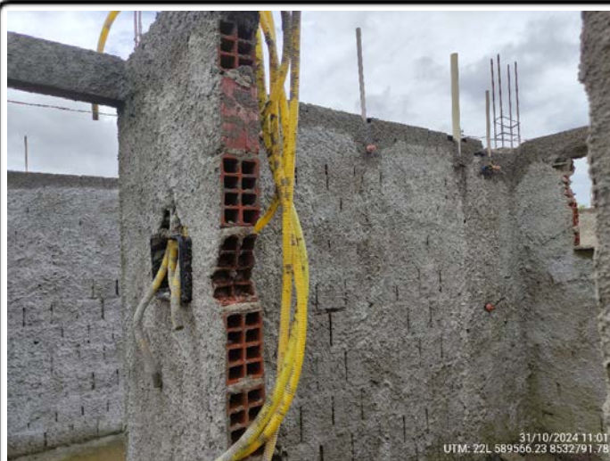
10-Quadra 21 Lote 02- infra elétrica e hidráulica banheiro UTM: 22L 589566.23 8532791.78 - 31/10/2024
