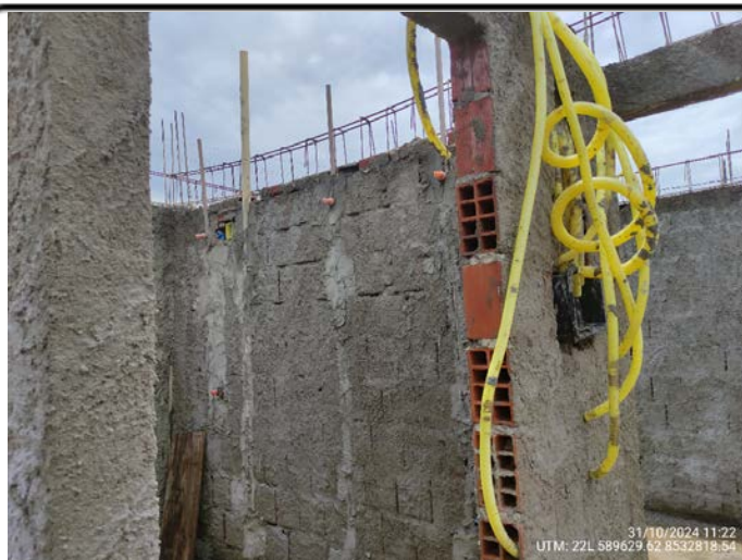
51-Quadra 21 Lote 09- infra elétrica e hidráulica banheiro UTM: 22L 589629.62 8532818.54 - 31/10/2024
