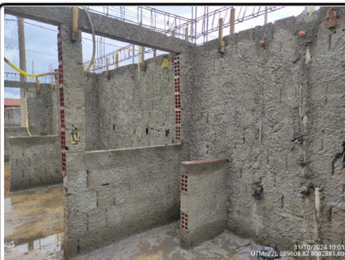
20-Quadra 12 Lote 04 - instalações registros de pressão e gaveta área de serviço e cozinha UTM: 22L 589608.82 8532881.60 - 31/10/2024
