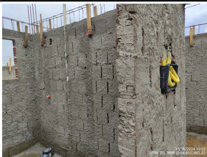
21-Quadra 12 Lote 04 - instalações hidráulicas e elétricas posicionadas no banheiro UTM: 22L 589610.64 8532882.22 - 31/10/2024
