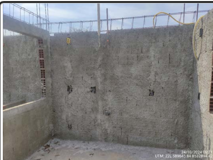
28-Quadra 11 Lote 12 - pontos hidráulicos e elétricos Cozinha e armadura de viga posicionada UTM: 22L 589645.84 8532894.42 - 24/10/2024
