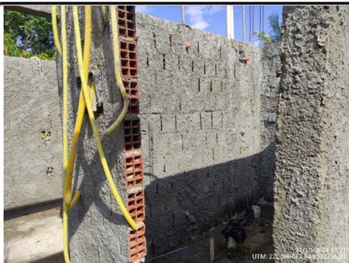
23-Quadra 08 Lote 05- infra elétrica e hidráulica banheiro UTM: 22L 589617.84 8532755.01 - 31/10/2024
