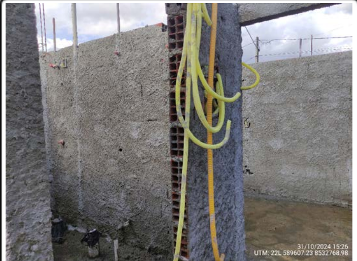
34-Quadra 08 Lote 07- infra elétrica e hidráulica banheiro UTM: 22L 589607.23 8532768.98 - 31/10/2024
