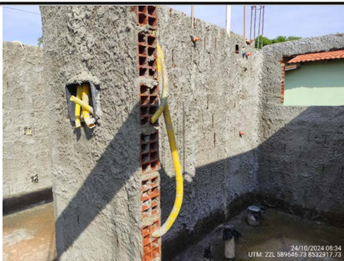
19-Unidade 10 - pontos Hidráulicos banheiro UTM: 22L 589646.73 8532917.73 - 24/10/2024
