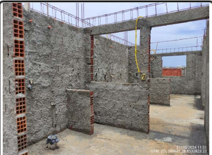
68-Quadra 21 Lote 12- infra elétrica e hidráulica UTM: 22L 589631.38 8532823.23 - 31/10/2024
