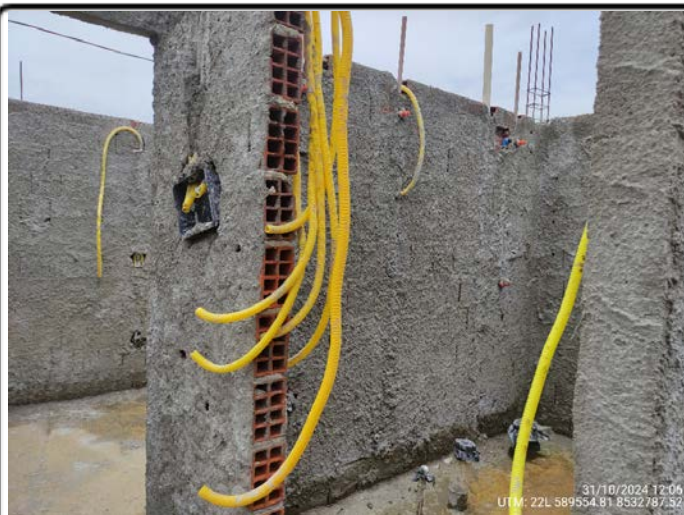
120-Quadra 21 Lote 21- infra elétrica e hidráulica banheiro UTM: 22L 589554.81 8532787.52 - 31/10/2024
