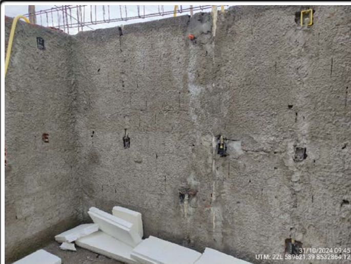
6-Quadra 12 Lote 02 - infra das instalações elétricas hidráulicas posicionadas UTM: 22L 589621.39 8532864.12 - 31/10/2024
