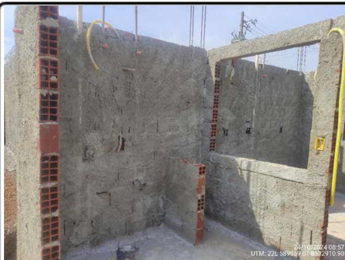
24-Quadra 11 Lote 11 - Pontos elétricos e Hidráulicos na área de serviço UTM: 22L 589659.01 8532910.90 - 24/10/2024
