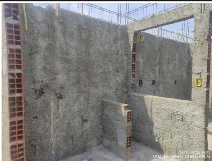
29-Quadra 11 Lote 12 - pontos hidráulicos e elétricos na área de serviço e armadura de viga posicionada UTM: 22L 589652.24 8532899.75 - 24/10/2024
