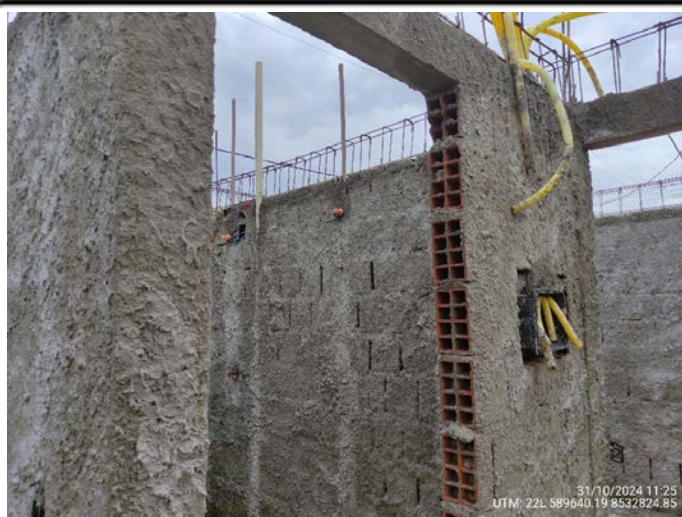
57-Quadra 21 Lote 10- infra elétrica e hidráulica banheiro UTM: 22L 589640.19 8532824.85 - 31/10/2024
