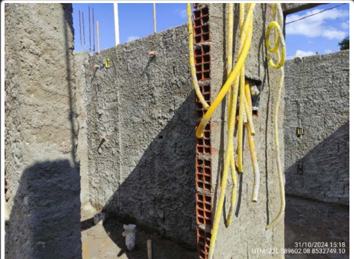
18-Quadra 08 Lote 04- infra elétrica e hidráulica banheiro UTM: 22L 589602.08 8532749.10 - 31/10/2024
